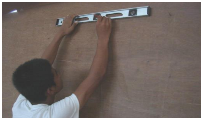
รูปที่ 91 การตีเส้นในแนวนอนด้วยระดับน้ำ (มาจาก อัจฉราพร ภูมานิล : 2560)
