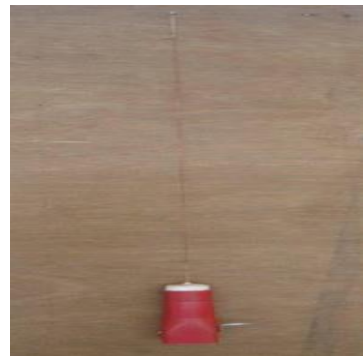
รูปที่ 90 การตีเส้นในแนวตั้งด้วยบักเต้า (มาจาก อัจฉราพร ภูมานิล : 2560)
