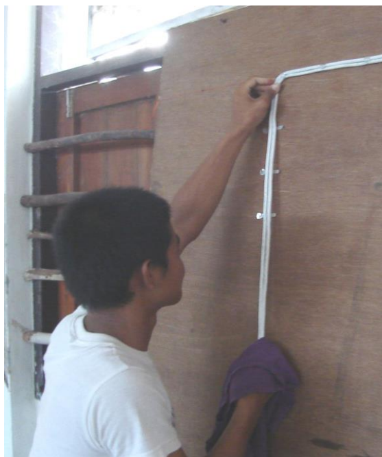
รูปที่ 97 การเดินสายไฟฟ้าในแนวตั้ง (มาจาก อัจฉราพร ภูพานิล : 2560)
