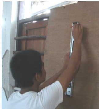
รูปที่ 89 การตีเส้นในแนวตั้งด้วยระดับน้ำ (มาจาก อัจฉราพร ภูมานิล : 2560)
